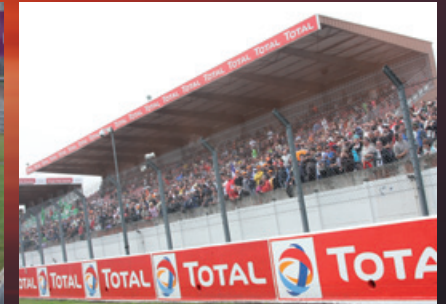
Murets de bord de piste, tribune/ Trackside walls, grandstand
